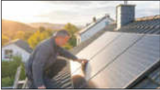
Fachkraft prüft Dachfläche und Befestigungspunkte vor der Planung einer Photovoltaikanlage. Foto: KI-generiert
