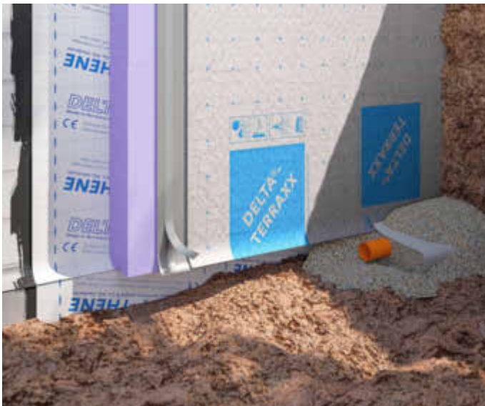
Moderne Drainagebahnen schützen Kellerwände bis zu 100 Jahre vor Feuchtigkeit und Stauwasser. Foto: Dörken/txn
